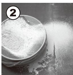
次に施工した同じ粉をふるいにかけます。目が細ければ細かい方がいいです。小さいキズの補修であれば、さらにパンストのように目の細かいものでふります。
