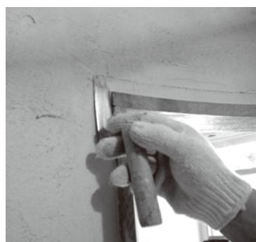
写真の様にコテで軽く1~2cm幅でラインをつける仕上げ方法もあります。額縁のアクセントを希望される場合に施工してください。
