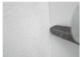
写真のような先が丸くとがった物で軽く削ります。
