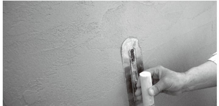
金ごでを少し浮かして、材料の粘りを感じながら横へ引くと、材料がこてに引っ張られる部分(さざくれ状)と平らになる部分がランダムに出る模様を表現することが出来ます。
