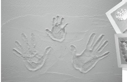
金ごてでほぼ平らにした後、手形を付けたい場所に手をしっかりと押さえつけます。手形を付ける場所は、少し厚めに塗っておいて下さい。手を離すとき、一気に剥がすと材料が付いてきますので、少しそのままにしてゆっくり少しずつ離します。
