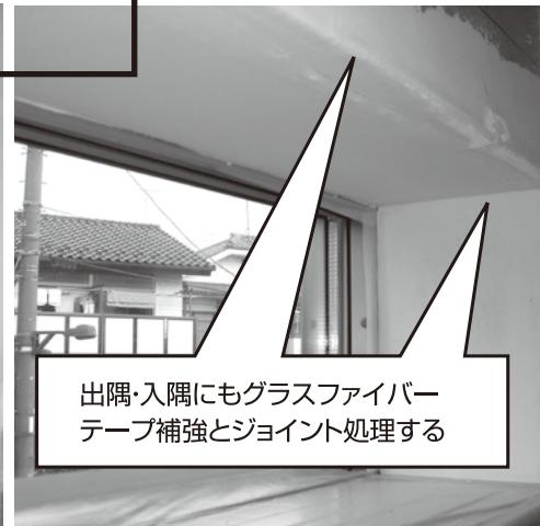
③ 2回目のアク止めシーラー「久米蔵」を塗って、常温で3時間経過したらベニヤ部全面にジョイント処理材(ジョイント処理2回目のパテ、ソフトクリーム位)を塗って帰ります。ジョイント処理材を塗ることでアクが出るかどうかを確認することができます。翌日、アクが出ていなければ白いままでアク止めが効いたということです。この状態でメルシーを施工するとアクは出ません。アクが出てシミになっているようであれば再度アク止めを行って下さい。
