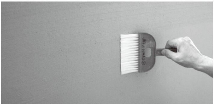
金ごでで、ほぼ平らにした後、写真のようにハケを寝かせながら横に引いています。ハケの角度でハケ溝の深さが変わります。ハケ目は寝かせれば柔らかく、立てれば荒く表情が出ます。
