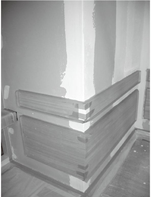
養生しておくことで、テープを剥がすだけでラインが綺麗に出せます。養生を剥がして、材料が盛り上がった部分を金ごてなどで軽く押さえると、綺麗に仕上ります。
