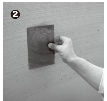
金ごでで、ほぼ平らにした後、①のようにほうきを寝かせながら横に引いています。ほうきの角度でほうき溝の深さが変わります。下敷きのような柔らかいもので凸部分をヘッドカットすると、やさしい表情に仕上ります(写真②)。材料がホウキについたら水洗いして下さい。ただし、水切りをタオルなどでよくしておかないと、材料に水がついてしまい、色ムラの原因になりますのでご注意下さい。
