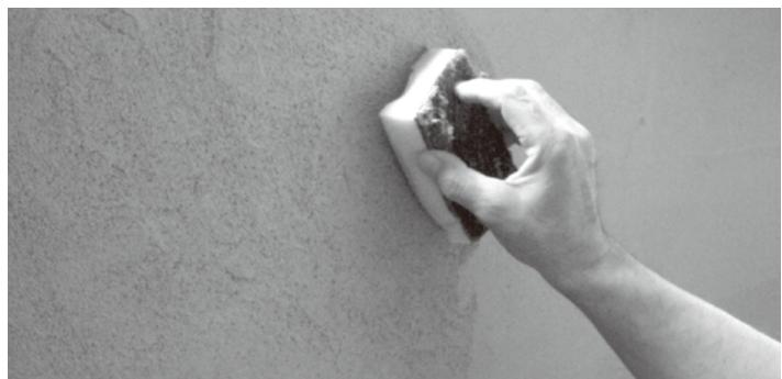
左写真①、②でつけたワラの面が多少乾いたらスポンジで半円を描くようにこすり付けます。すると、ワラが表面に出てきて表情が完成します。 材料がスポンジについたら水洗いして下さい。ただし、水切りをタオルなどでよくしておかないと、材料に水がついてしまい、色ムラの原因になりますのでご注意下さい。
