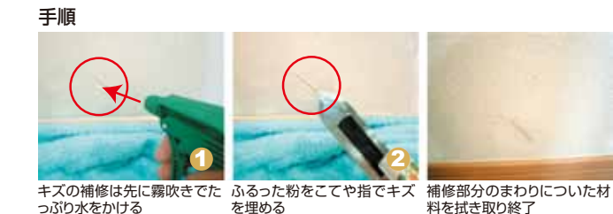
手順 1 キズの補修は先に霧吹きでたっぷり水をかける 2 ふるった粉をこてや指でキズを埋める 3 補修部分のまわりについた材料を拭き取り終了
