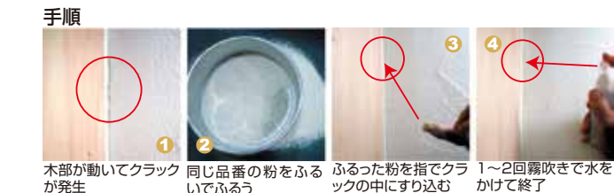
手順 1 木部が動いてクラックが発生 2 同じ品番の粉をふるいでふるう 3 ふるった粉を指でクラックの中にすり込む 4 1～2回霧吹きで水をかけて終了
